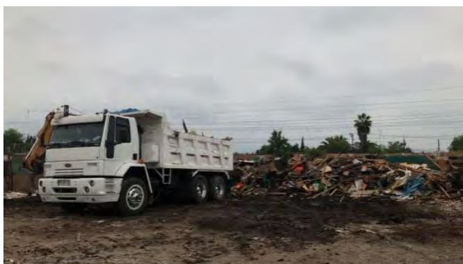
Retiro de escombros y traslado a botadero autorizado.
