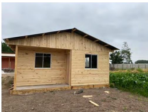
Entrega de vivienda prefabricada sector Santa Filomena, Huelquén
